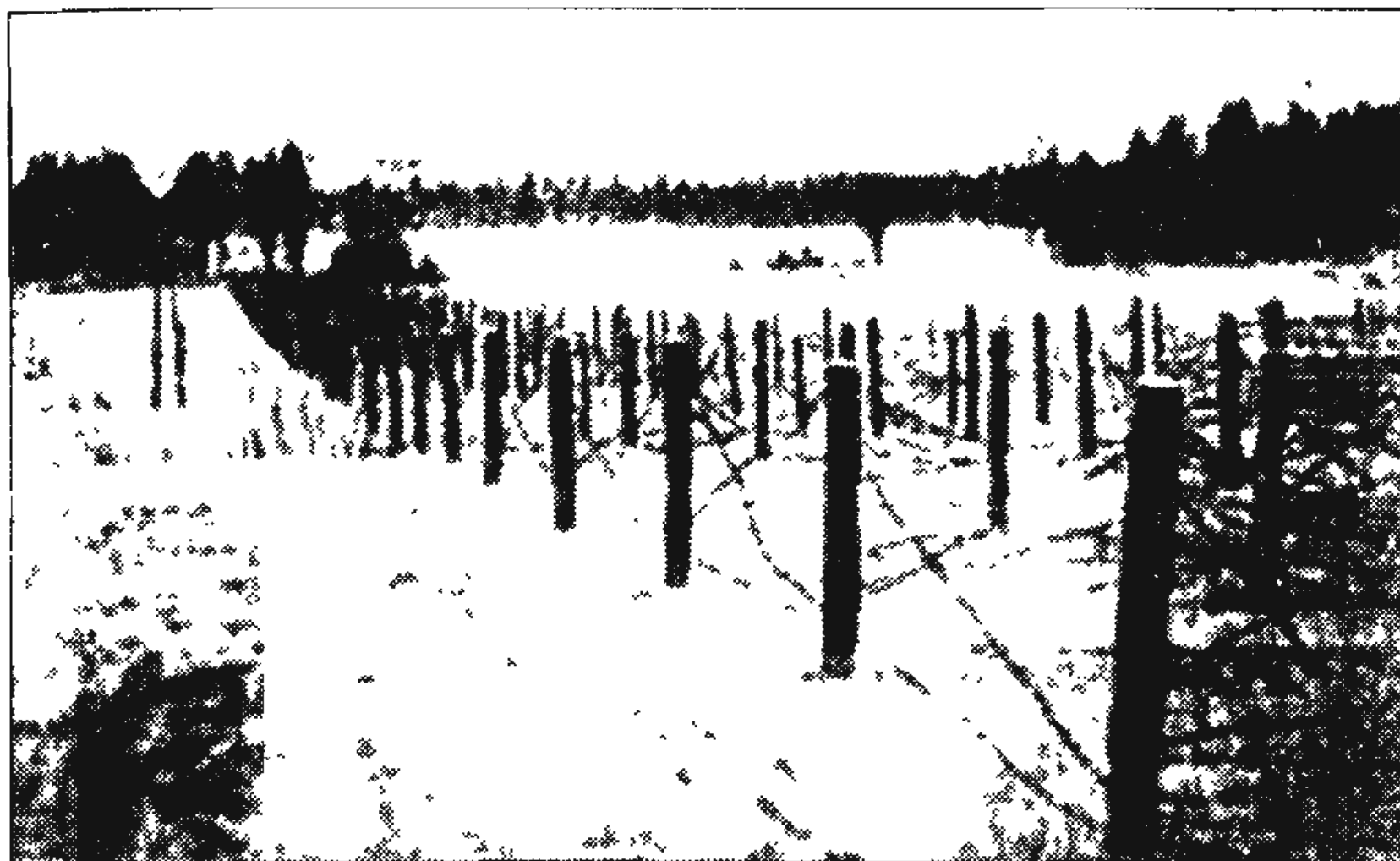
Линия Маннергейма Проволочные заграждения.
